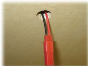
Kuva 2. Kytke ledit pikaliittimiin. Liitä ledit heti kiinni, jotta vältetään liitinjohtojen karkaaminen paneelin taakse ulottumattomiin.
